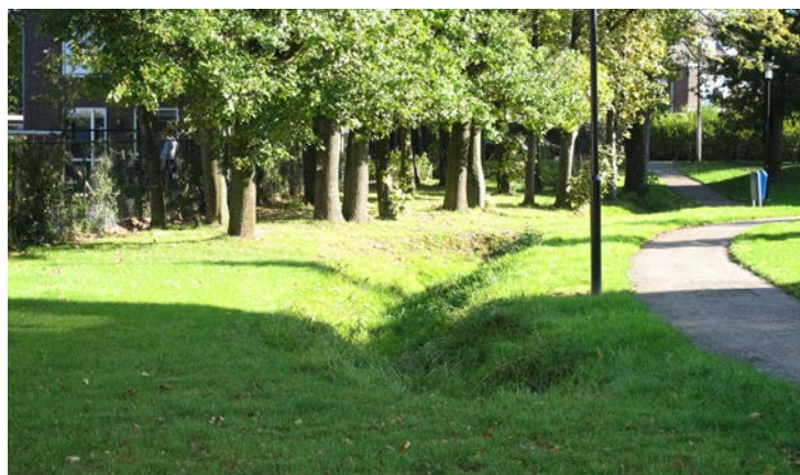
Groene goot kan water afvoeren naar infiltratieveld (Heerlen)
