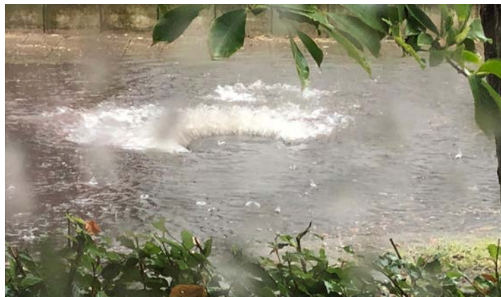
Riool kan toevoer water niet aan en loopt over, Dommer van Poldersveldweg
