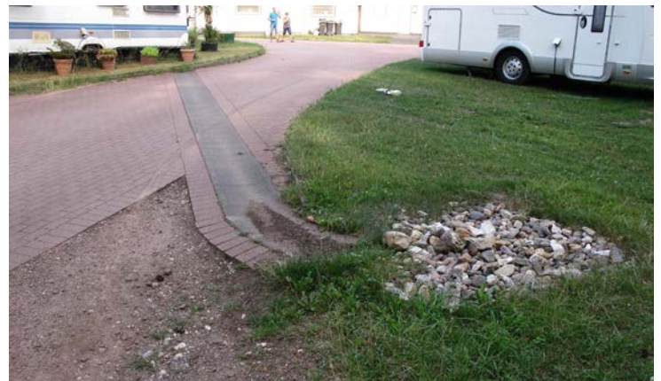
Voorbeeld van zichtbare wateropvang en infiltreren (Eiffel)
