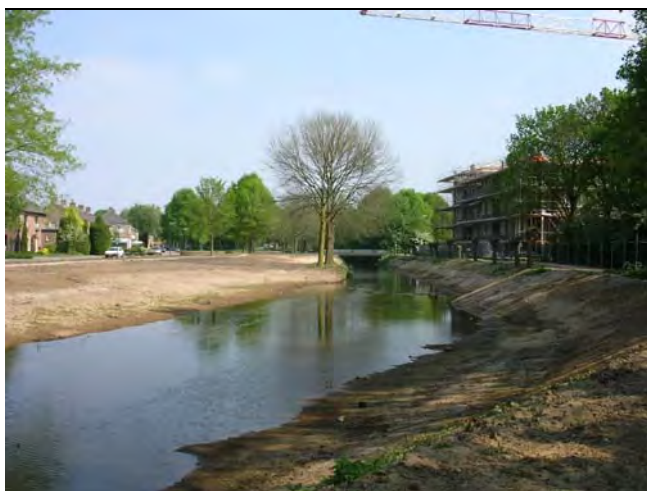
Figuur 4.6 Recent aangelegde oevers van de Hertogswetering
